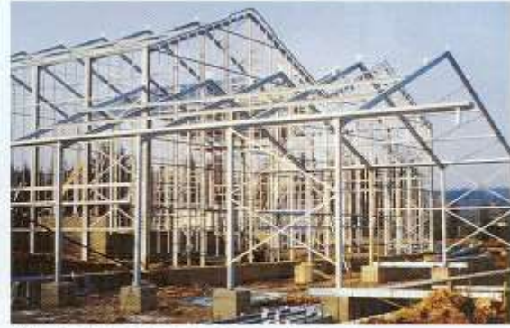
Abb. 5 Im Bau befindliche Schaugewächshäuser (Aufnahme G. Zenk)
