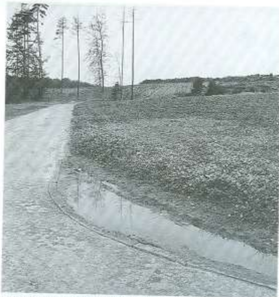
Abb. 3 Staunässe am Wegesrand. Darüber durch Versauerung stark geschädigte, vergilbte (hellere) Grünsaatsaat (Archivbild Botanischer Garten)
