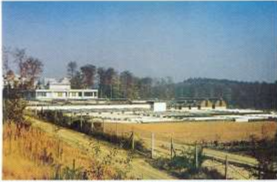
Abb. 4 Im Bau befindliches Gartengebäude mit Anzuchtgewächshäusern und Frühbeeten im Vordergrund (Aufnahme W. Nultsch)
