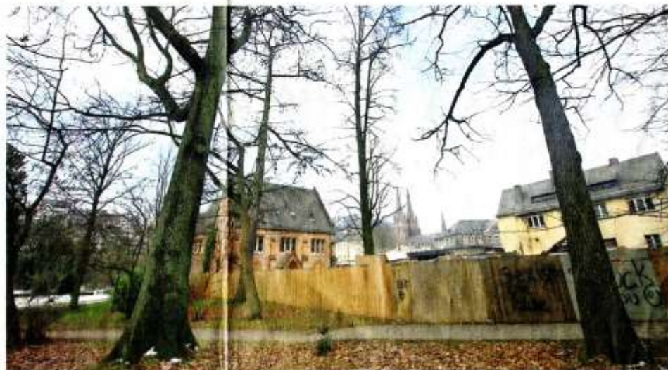
Gartendenkmal trifft Großbaustelle: Der Neubau des Campus Firmanei ruft Umweltschützer auf den Plan, die die Zerstörung des Alten Botanischen Gartens befürchten. Foto: Thorsten Richter
